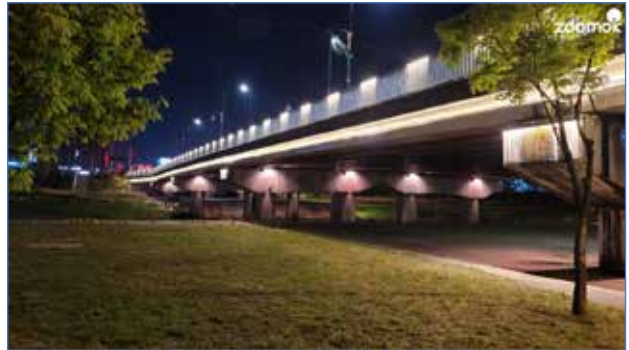
원주천 교량야간경관 개선 사업 ▶
