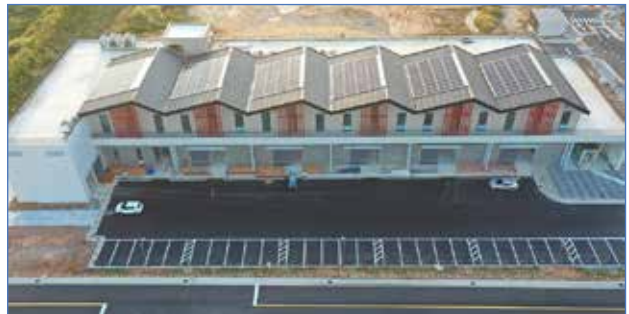
에너지신기술연구소 ▶ 건물일체형 태양광발전장치 설치
