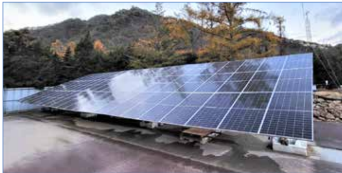
◀ 월악산국립공원 주차장 태양광발전장치 설치
